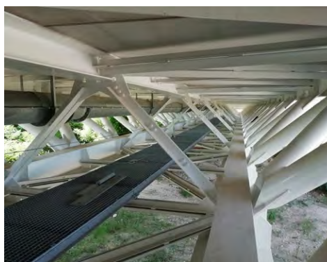
10. Vista dell'interno del cassone; si notano la passerella di ispezione appoggiata sulla controventatura inferiore e le tubazioni appese
