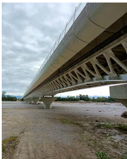
11. Ulteriore scorcio dell'orditura metallica e della veletta architettonica di bordo
