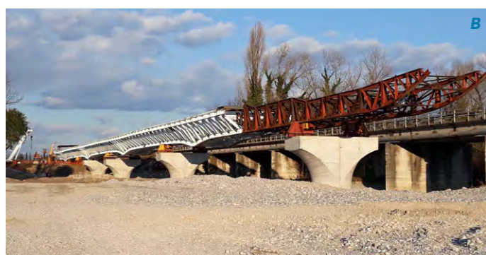
8A e 8B. Fasi di varo di punta con ausilio di rulliere e avambecco. Si nota la presenza del ponte pre-esistente, lasciato in esercizio durante la costruzione
