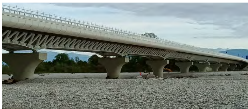
12. Vista complessiva del viadotto in esercizio dall'alveo dopo la demolizione del ponte pre-esistente
