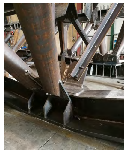
5. Nodo tipico fra corrente inferiore, aste di parete e diaframmi della travatura reticolare di parete
