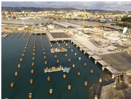
Fase iniziale costruzione impalcato
