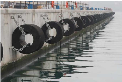
Fronte banchina a fender montati Situazione finale
