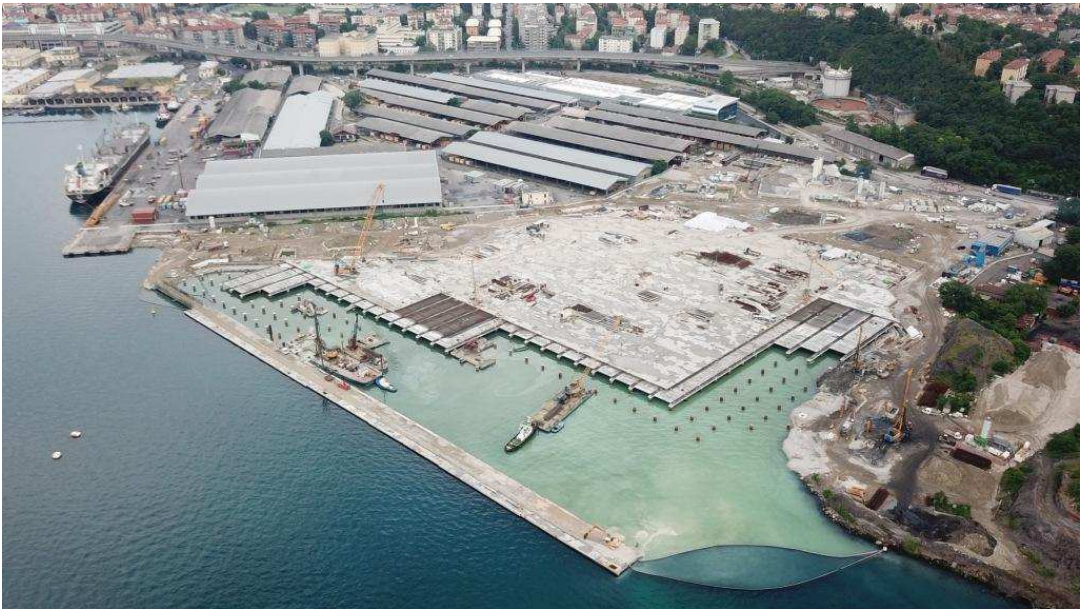
Fase avanzata di costruzione dell'impalcato
