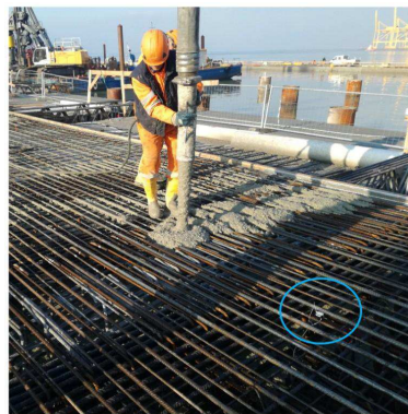
Fase di getto impalcato con sensore di temperatura
