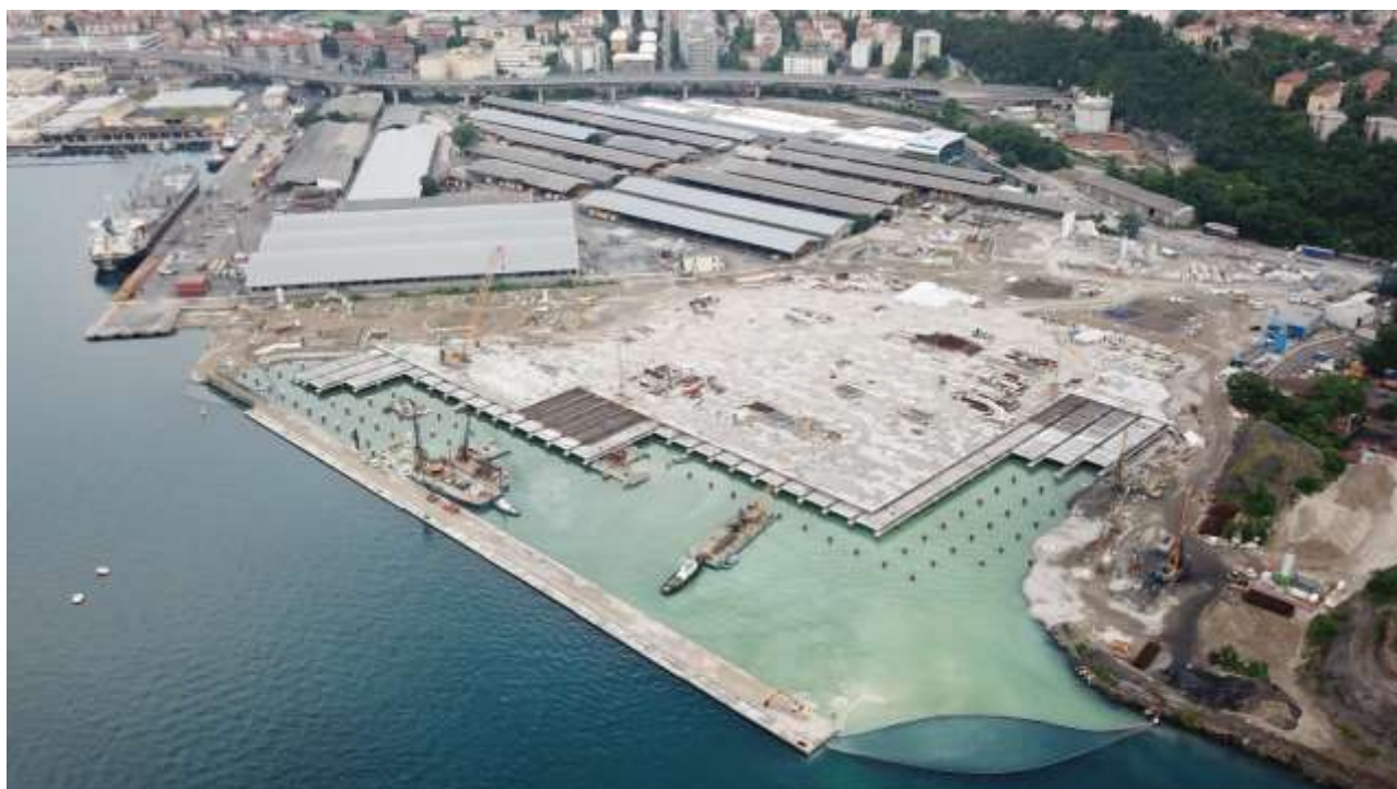
Figura 7 - Fase avanzata di costruzione della banchina su pali.
