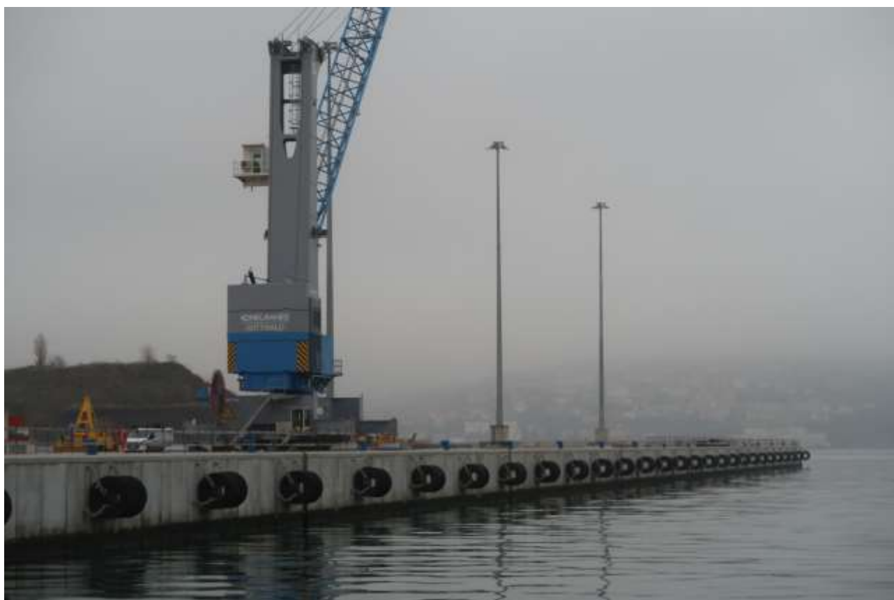
Figura 4 - Lato fronte mare con una delle gru a servizio dello scarico dei containers dalle navi.
