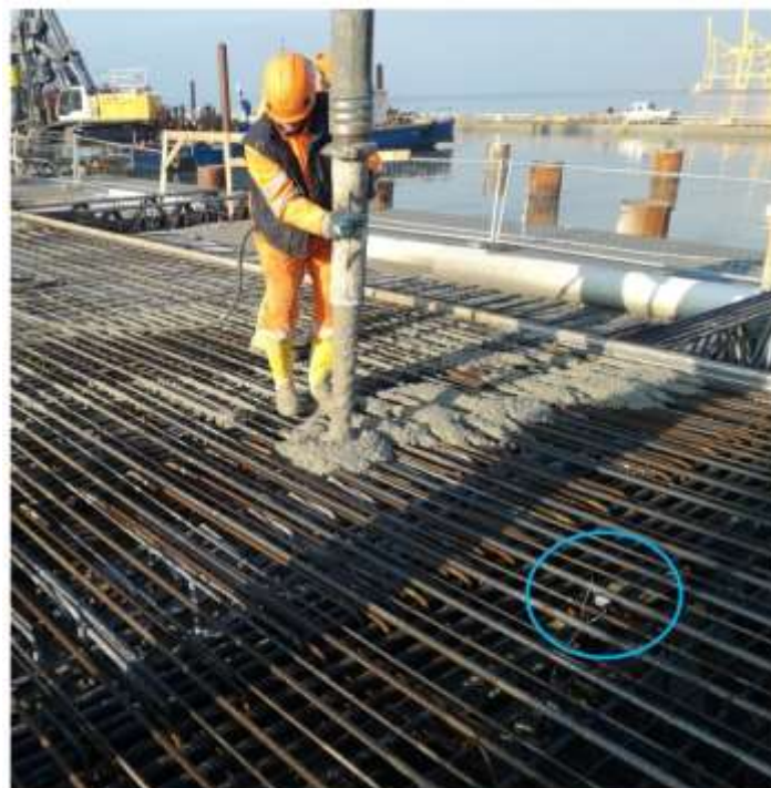
Figura 10 - Fase di getto dell'impalcato con evidenziato uno dei sensori di temperatura, che è stato posizionato all'interno della soletta ed annegato nel getto, utilizzato per valutare lo stato di resistenza raggiunto dal calcestruzzo.
