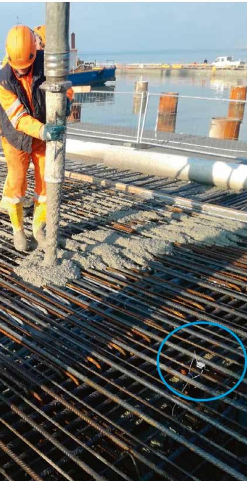
↓ Figura 4 - Applicazione di un sensore nel getto. Fissaggio del sensore all'armatura della soletta (immagine di dettaglio a destra)
