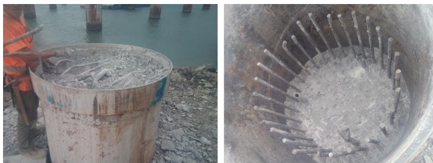
Figura 4. Dettaglio testa palo (n. 758) con materiale di spurgo in demolizione (sx) e dopo la scapitozzatura (dx).
