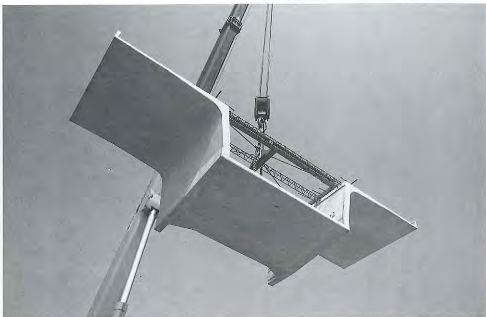
10. Particolare dei gusci-cassero prefabbricati: si evidenziano i tralicci interni necessari per conferire adeguata resistenza al guscio durante le fasi di trasporto e posizionamento; 11. Particolare del guscio-cassero durante il sollevamento (elemento da posizionare in corrispondenza di una pila); 12. Fase di posizionamento dei conci prefabbricati in corrispondenza della prima campata eseguita; 13. Fase di posizionamento dei conci prefabbricati in prossimità di una spalla.
