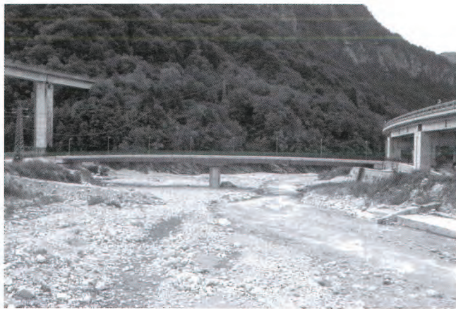
Fig. 3. Vista da valle del ponte sul fiume Fella.
