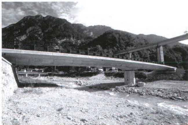
Fig. 1. Vista da valle del ponte sul fiume Fella.
