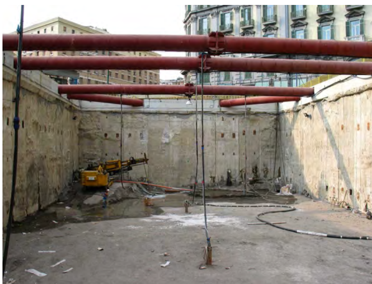
Figura 2: pozzo in diaframmi per la metropolitana di Napoli
