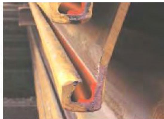
Figura 11: forma tipica del giunto longitudinale tra due palancole metalliche e giunto con profilo in poliuretano impermeabilizzante
