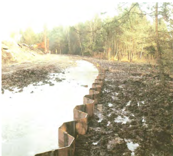
Figura 13: possibili utilizzi delle palancole metalliche come contenimento di discarica o opere provvisorie per la costruzione di una pila da ponte
