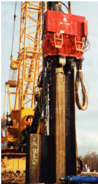
Figura 12: utilizzo di vibratore per l'infissione contemporanea di due elementi di palanca
