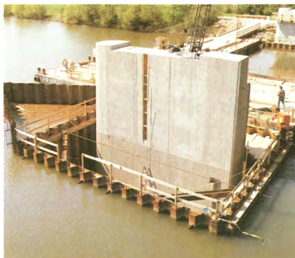
Figura 13: possibili utilizzi delle palancole metalliche come contenimento di discarica o opere provvisorie per la costruzione di una pila da ponte
