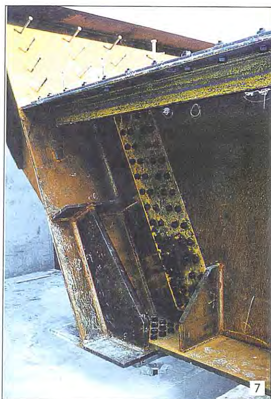
Fig. 6 - Particolare del concio metallico di spalla visto da sopra; è visibile la fascia terminale del concio che andrà successivamente riempita di calcestruzzo e sulla quale si contrasteranno i dispositivi elastoplastici di dissipazione dei carichi sismici.
