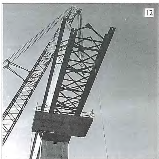
Fig. 10 - Una campata del ponte dopo il posizionamento delle piastre prefabbricate in c.a. al di sopra della travatura metallica.
