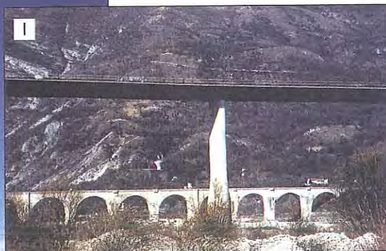
Fig. 2 - Vista d'insieme del ponte dopo il posizionamento delle piastre prefabbricate in c.a. al di sopra della travatura metallica.
